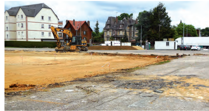
Début des travaux semaine 21
