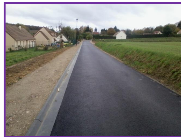
Rue de la Groutte - Authevernes – pendant les travaux de chaussée et gestion des eaux pluviales
