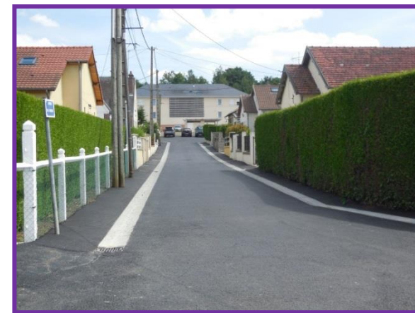
Avenue du Bouloir – Gisors après les travaux de bordures et enrobés
