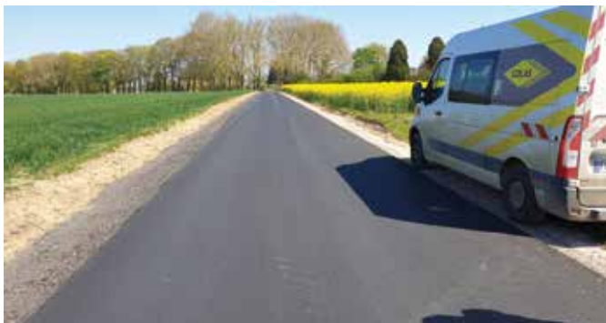
La rue du Moulin à Villers-en-Vexin fait partie des chantiers réalisés depuis début 2021
