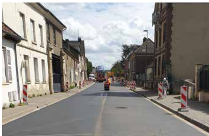
À Gisors, la phase 2 de la rue de la Libération a été réalisée.
