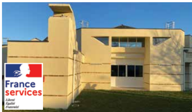
L'extérieur du bâtiment s'est également offert un relooking réussi
