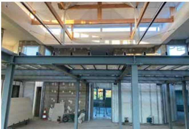
L'ancien centre social Paul-Éluard, entièrement restructuré et rénové, accueillera sur plus de 500 m 2 et 2 niveaux la future structure au service des jeunes, de la famille et des seniors.
