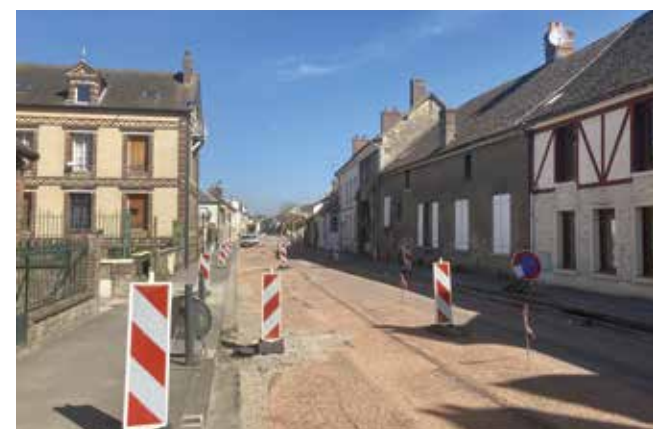
Les travaux de voirie entrepris rue de la Libération à Gisors entrent dans le cadre des investissements prévus au budget 2021
