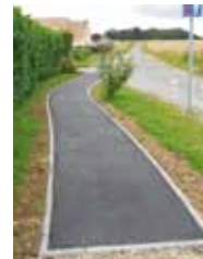
Chemin piétonnier Rue de la ferme brulée à Thierceville
