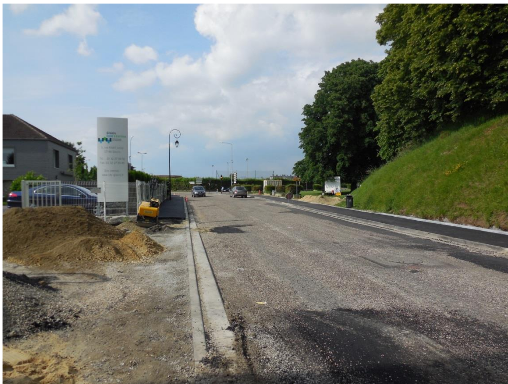
Rue Albert Leroy – pendant les travaux de chaussée et trottoirs
