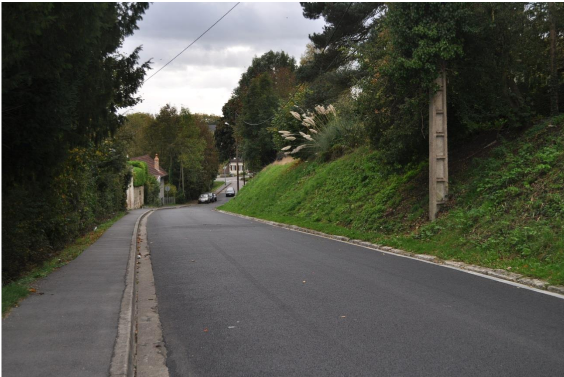
Rue du Cours Renault – après les travaux de bordures et enrobé
